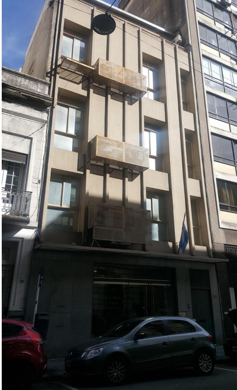
Se recomienda abrir las fisuras y sellarlas, posteriormente retirar todo revoque de recubrimiento que se encuentre en condiciones de desprendimiento. Posteriormente revocar los sectores reparados con concreto y finalmente pintar integralmente la fachada con todos sus elementos constitutivos y sus partes componentes.
