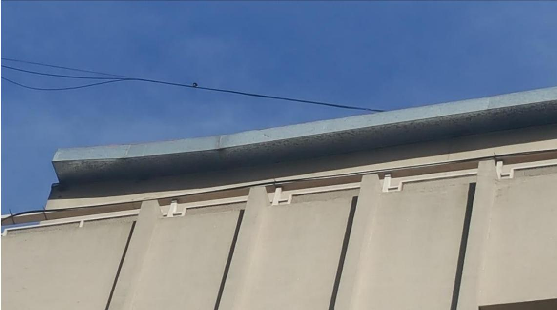
REPARACIÓN INTEGRAL DE TODO EL PARAMENTO DE LA FACHADA FRONTAL QUE INCLUYA SELLADOS DE FISURAS, HIDROLAVADO, REPARACIÓN DE ALBAÑILERÍA Y PINTURA IMPERMEABLE EN TODA SU EXTENSIÓN.
